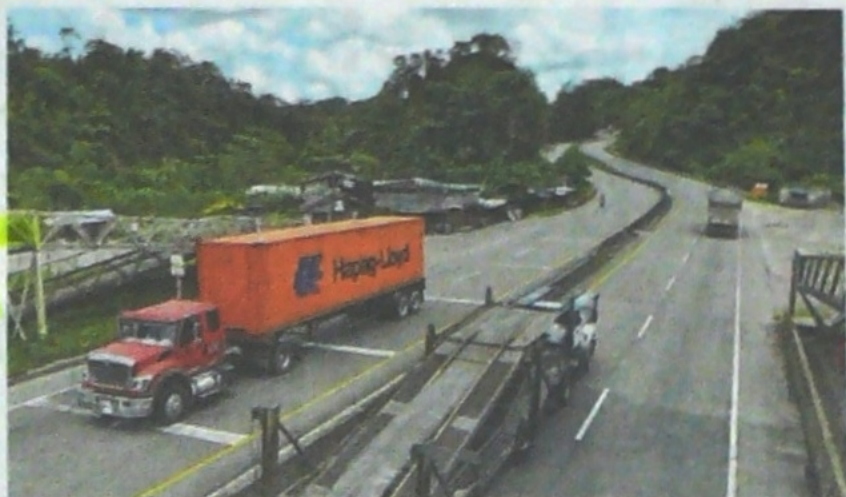
Doble calzada al mar. Aún faltan alrededor de 34 kilómetros de construcción de la vía para completar la doble calzada, de los cuales 17 son los más complejos.
