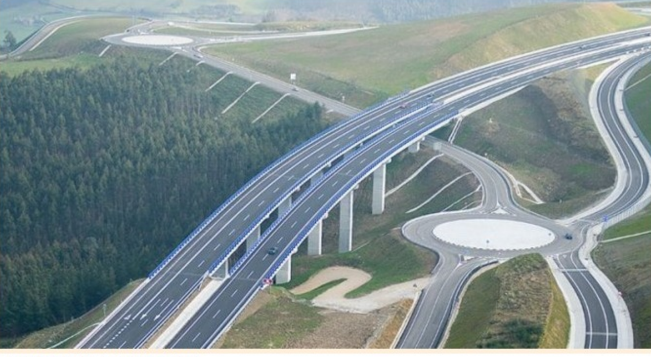
Foto de archivo infraestructuras OHL.
