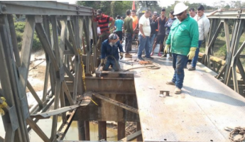
Se reparó la capa de rodadura, la remoción y cambio de barandas / Foto: Cortesía
