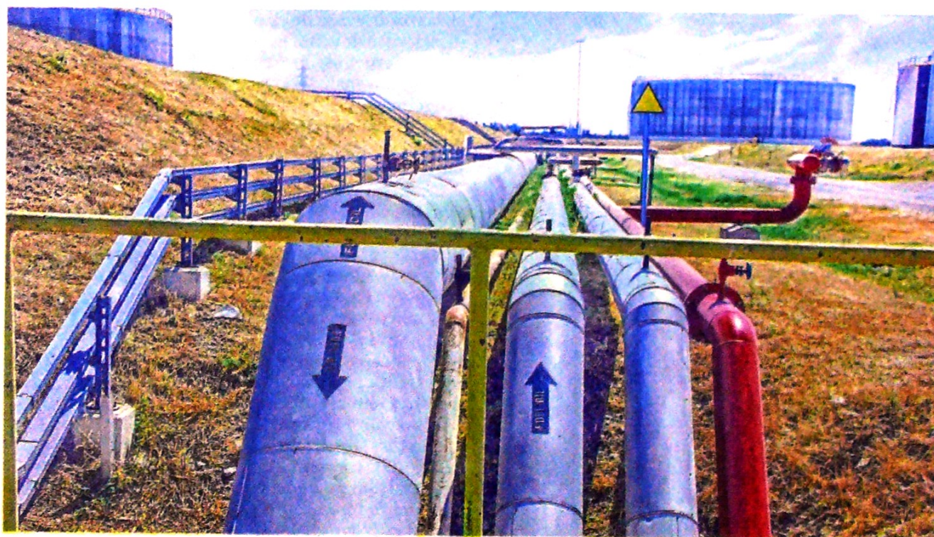
El gasoducto Jobo - Medellín - Mariquita - Bogotá, tendría una inversión superior a los US$350 millones para su montaje. iStock
