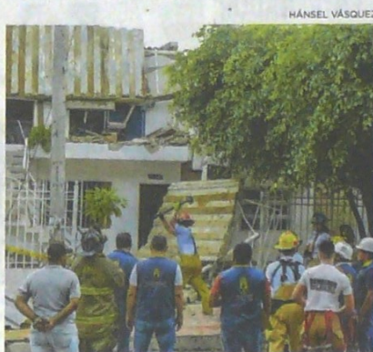
Bomberos previo a la demolición de la vivienda.
