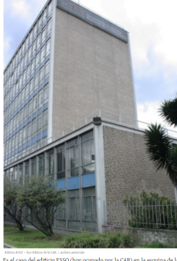
Edificio ESSO - hoy edificio de la CAR / Archivo personal
