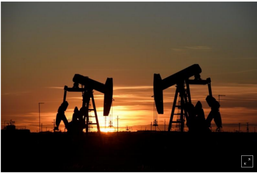
Sistema de bombeo opera en yacimiento petrolero en Midland, Texas, EEUU, 22 agosto 2018. REUTERS/Nick Oxford/Imagen de archivo
