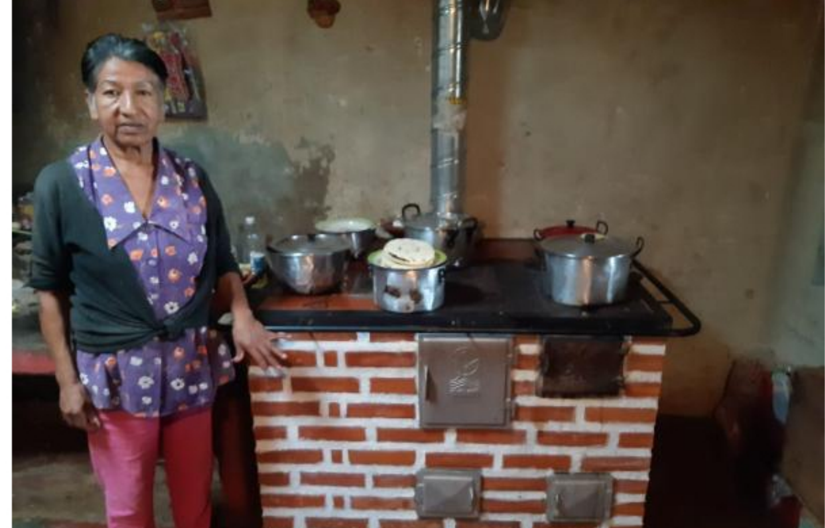
Se trata de un sistema practico pues están construidas en ladrillo y herrajes, tienen un horno, 4 fogones, un caldero, chimenea, compartimiento para leña, cenizas y ventilación. Foto: Archivo particular
