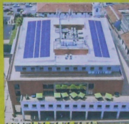
En el edificio de Comfenalco Valle, sobre la Calle Sta. se están instalando los primeros paneles.
