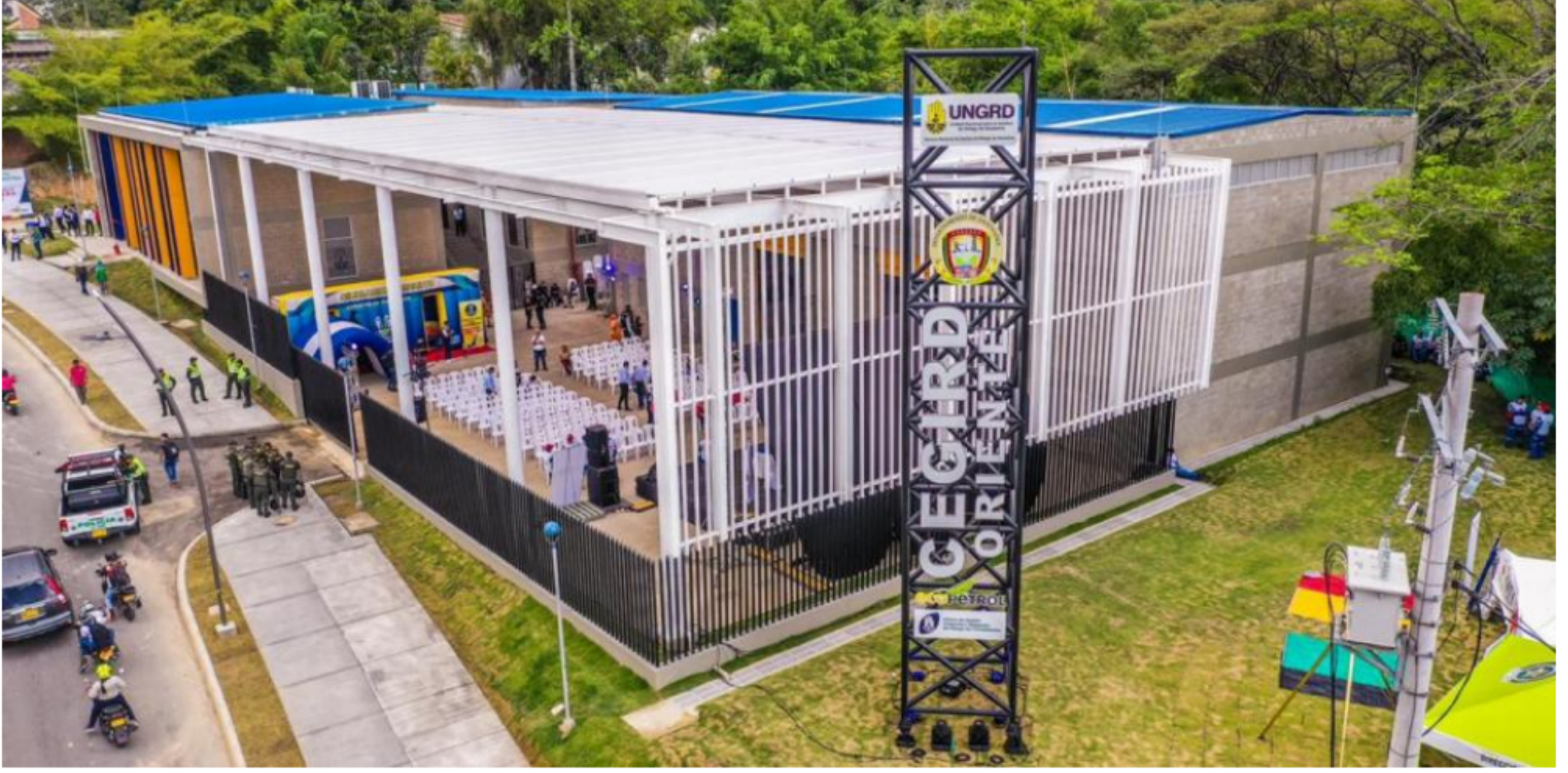
El mobiliario tendrá el sistema de 'Bambi Bucket' contra incendios. Foto: Gobernación de Santander
