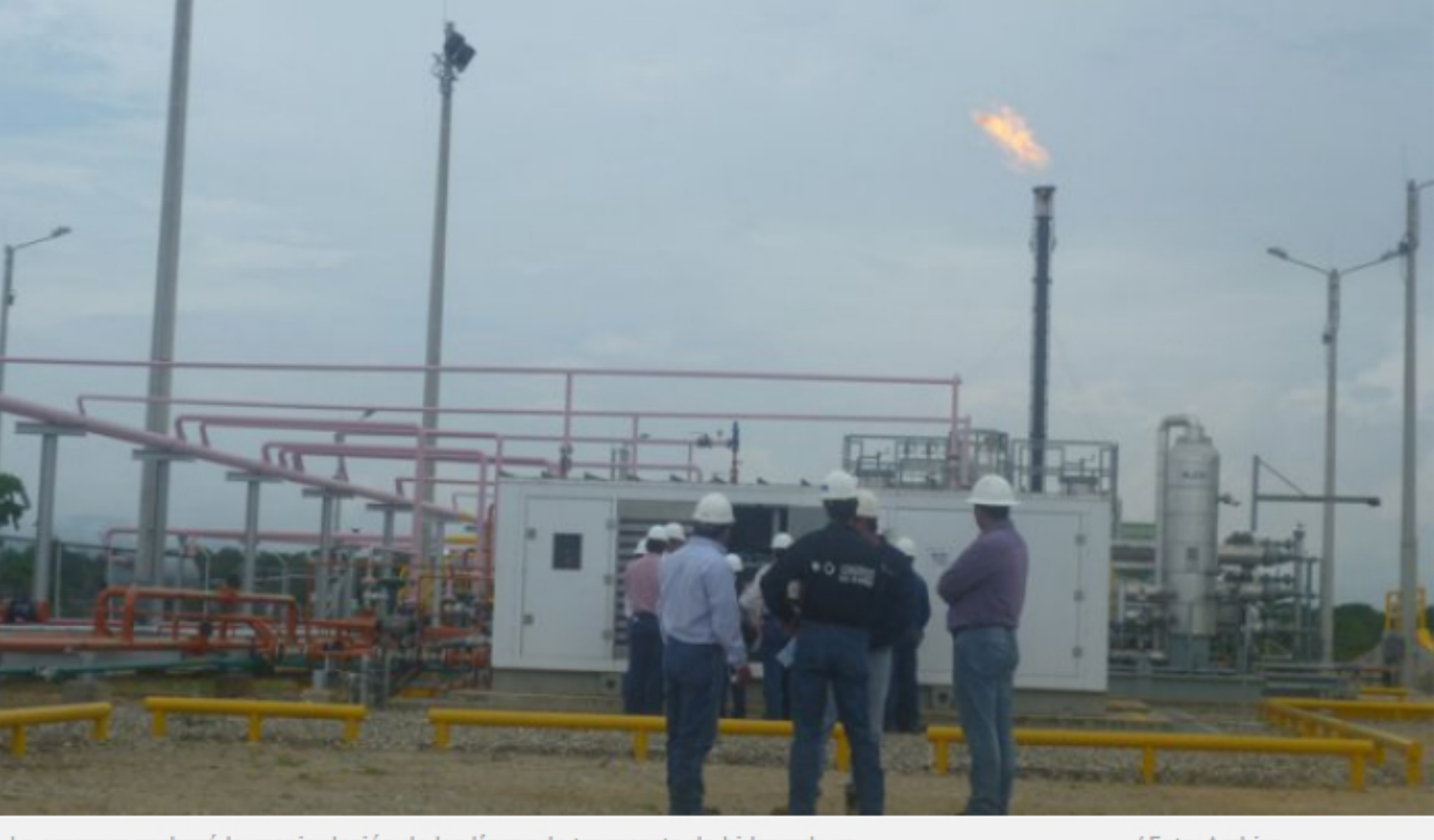
La empresa rechazó la manipulación de las líneas de transporte de hidrocarburo. / Foto: Archivo
