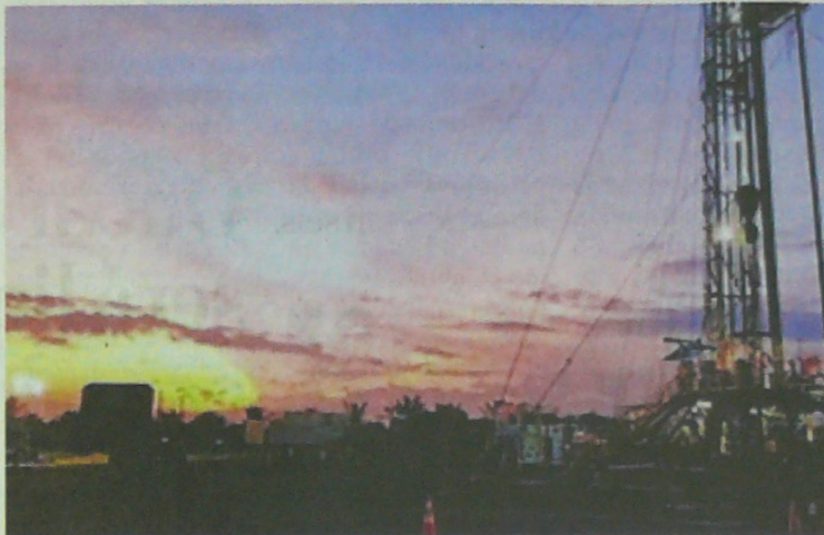
Vista del proyecto Caporo Norte, donde están ubicados los 15 pozos de gas.
