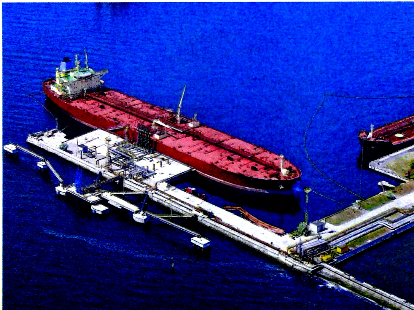
“El área de atraque deberá tener mínimo 450 metros de largo, 123 metros de ancho y 13,69 metros de profundidad”: Dimar. iStock
