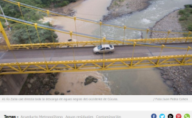
En Río Zaba van directa toda la descarga de aguas negras del accidente de Cúcuta. / Foto: Juan Pablo Colera
