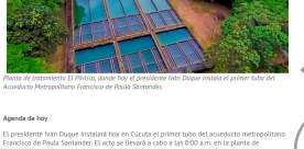
Planta de tratamiento El Pórtico, donde hoy el presidente Iván Duque instala el primer tubo del Acueducto Metropolitano Francisco de Paula Santander.
