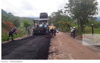
Archivo / VANGUARDIA. Para el mantenimiento y mejoramiento de las vías rurales con maquinaria pesada y nuevas tecnologías, construcción de placas huella, obras de drenaje y obras de contención, el Gobierno Nacional abrió la convocatoria para el Programa Colombia Rural en convenio con la Gobernación y las Alcaldías municipales.
