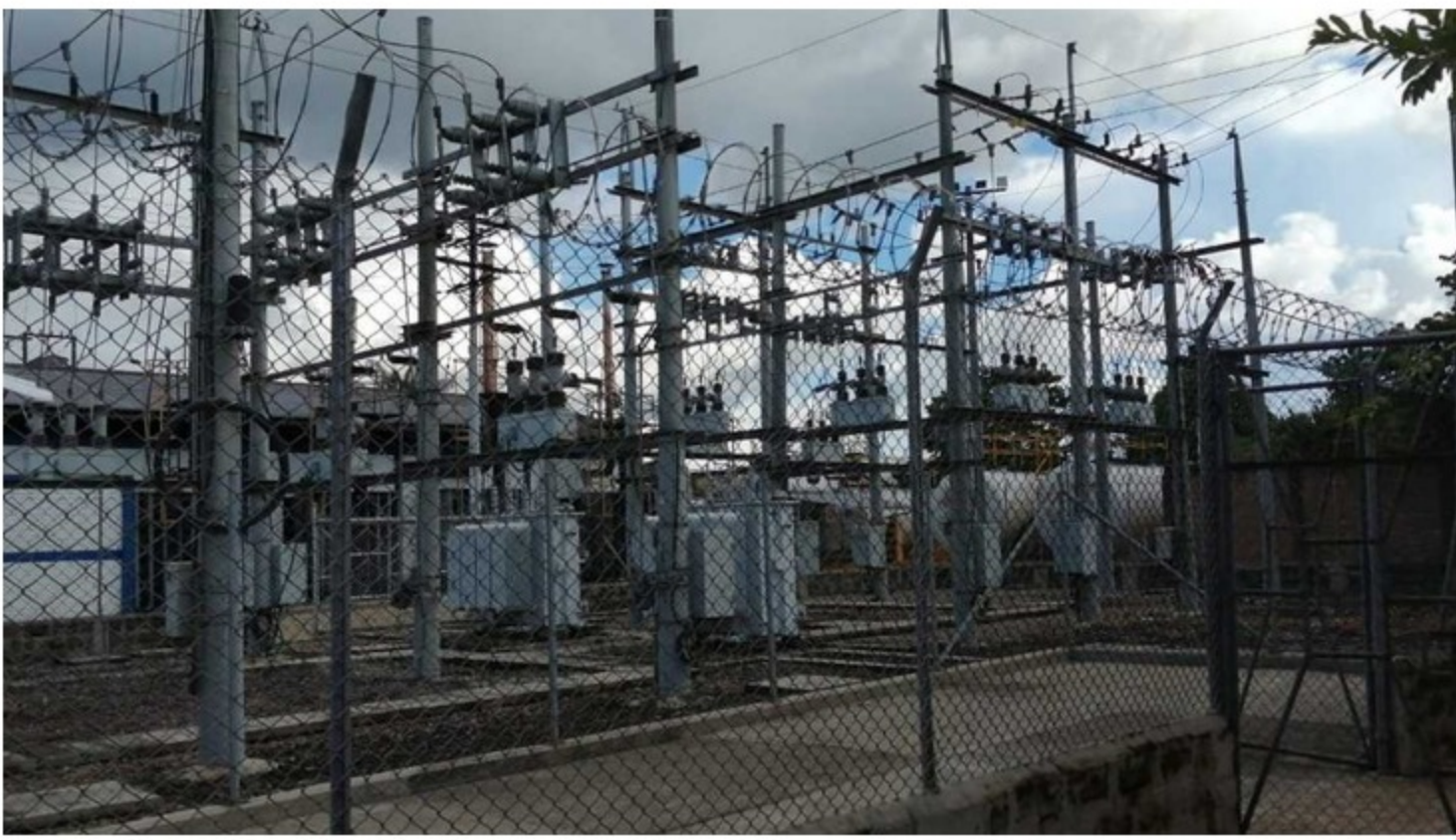
La construcción de esta obra generó alrededor de 1.200 puestos de trabajo, con una significativa contratación de mano de obra local. - Foto: Magazín Arú Pacomá
