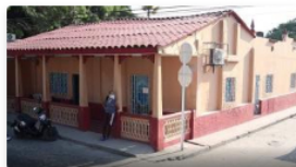
Avanza restauración de edificaciones antiguas en Melambo
