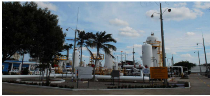
Con esta obra se garantiza el suministro de gas natural para todos los sectores en cualquier zona de Colombia - Foto: Promigas
