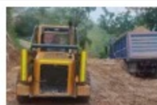
Avanzan trabajos para mitigar afectación por lluvias en vías de Lebrija
