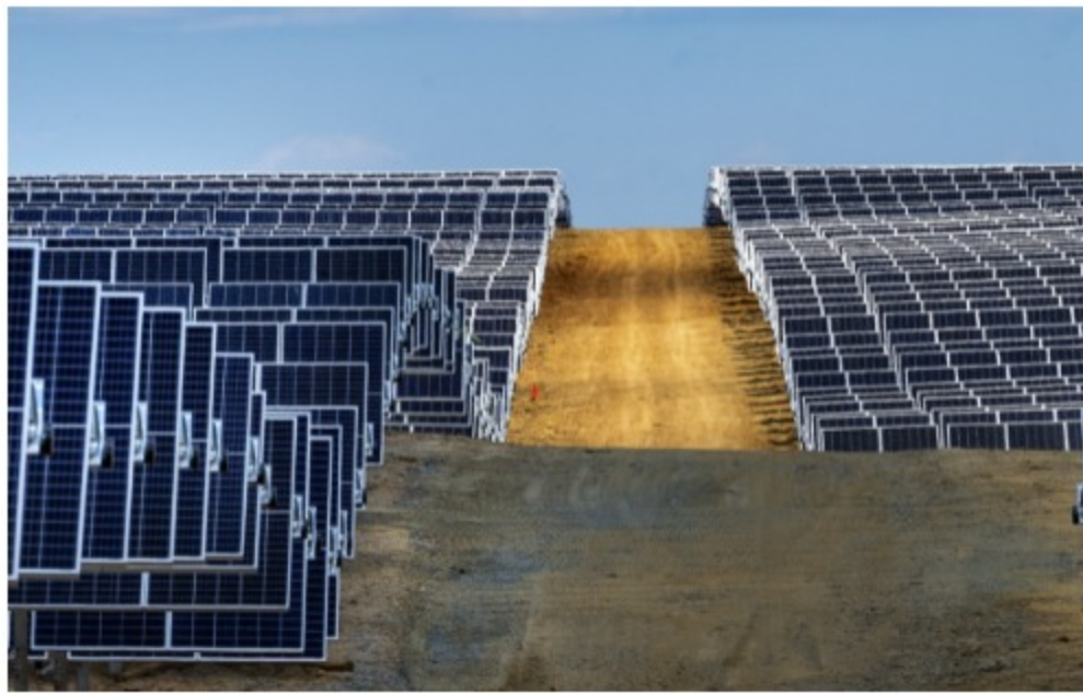
El Parque Solar San Fernando.
