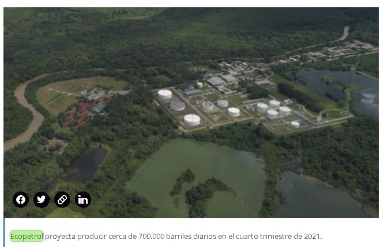
Ecopetrol proyecta producir cerca de 700.000 barriles diarios en el cuarto trimestre de 2021.
