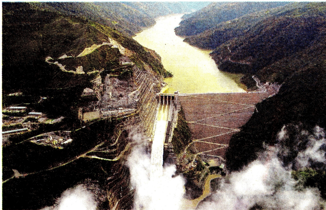
En los últimos dos días las vías de acceso a la megaobra están bloqueadas lo que no ha permitido su desarrollo.
