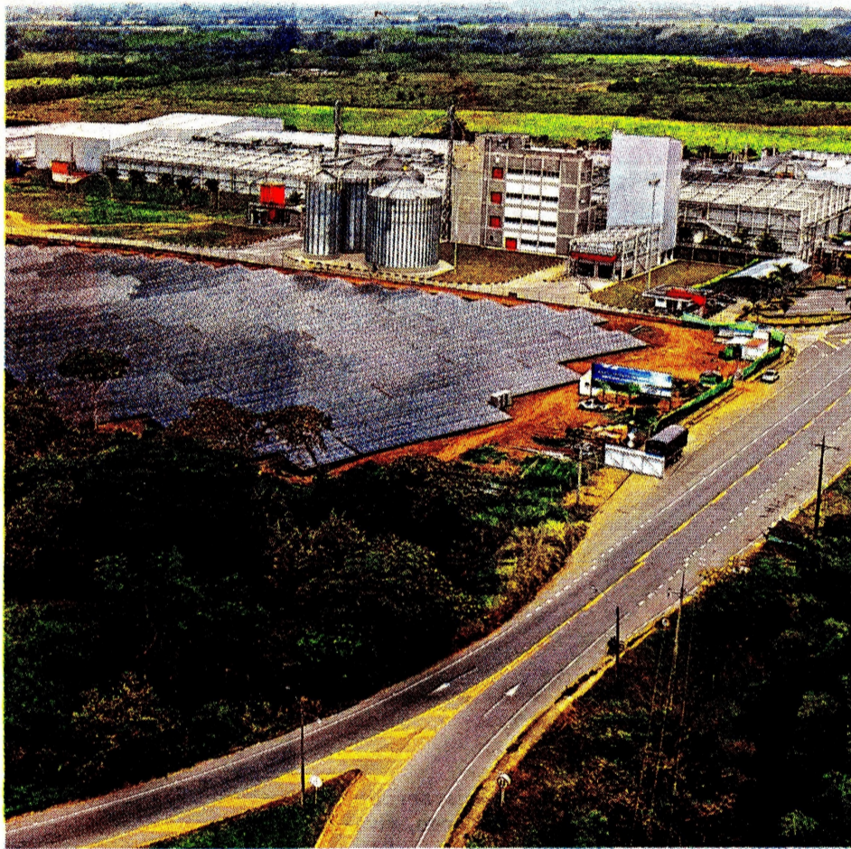
La planta de Colombina utiliza una granja solar producirá 2.716.000 kWh/año de energía. GEC
