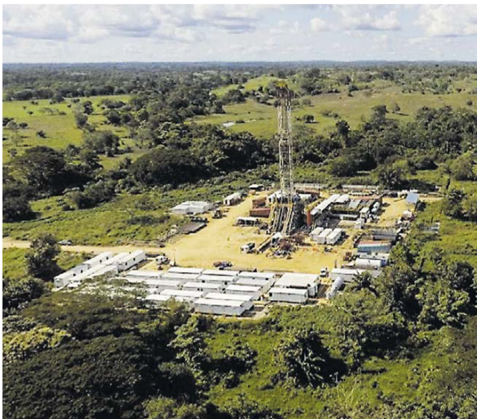
Pozo Arrecife-1ST en Córdoba, administrado por la empresa Hocol.
