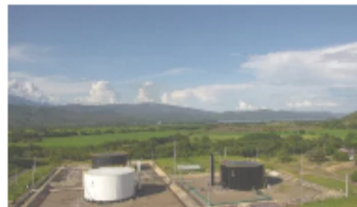
Los tres parque solares de Ecopetrol en el Huila 25/01/2021 En «Regional»
