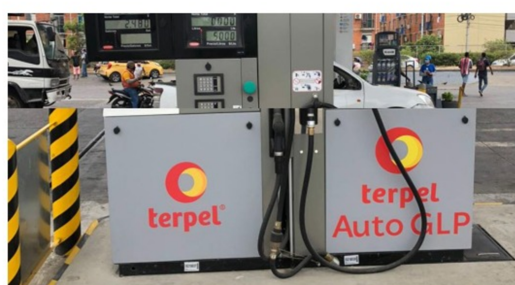
Estación pública de gas licuado de petróleo (GLP) en Cartagena. Terpel
