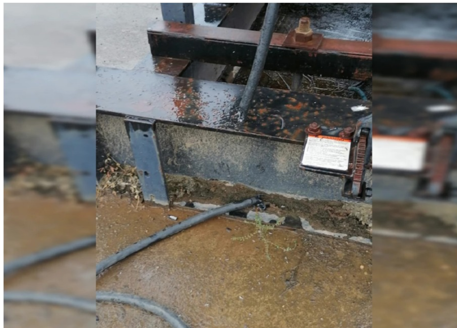
BLU Radio. Daños campo Llanito / Foto: Ecopetrol
