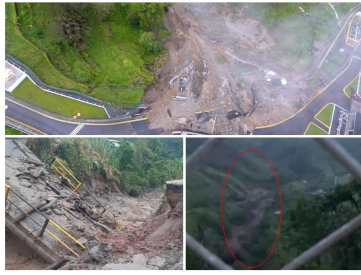
La emergencia se registró en límites entre Nariño y Putumayo. Hay afectaciones viales y temen que emergencia se agrave.
