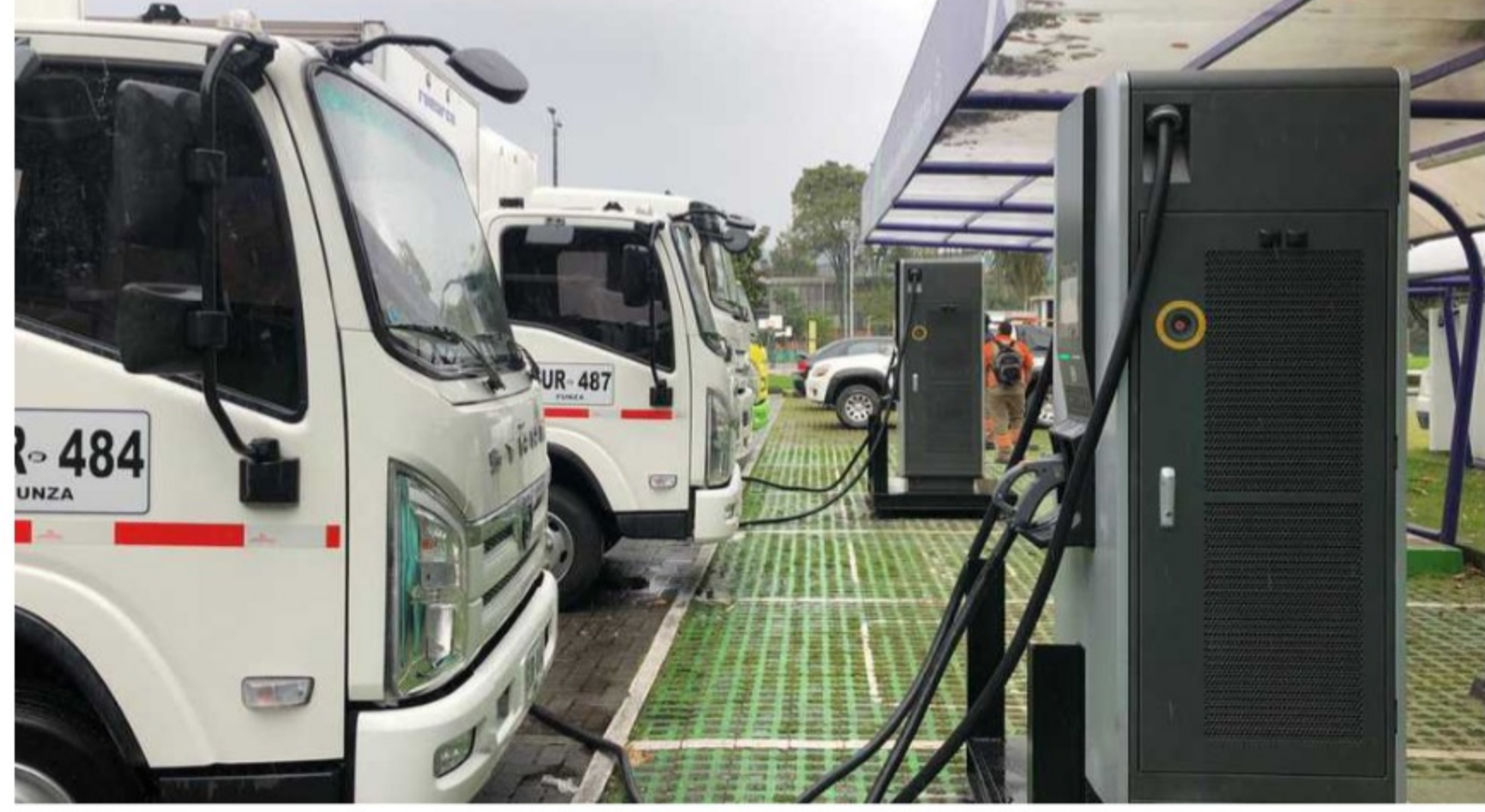
Estación de carga de Enel - Foto: Cortesía Enel
