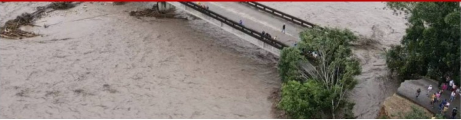
Falla de infraestructura en Puente Bojabá. / Cortesía
