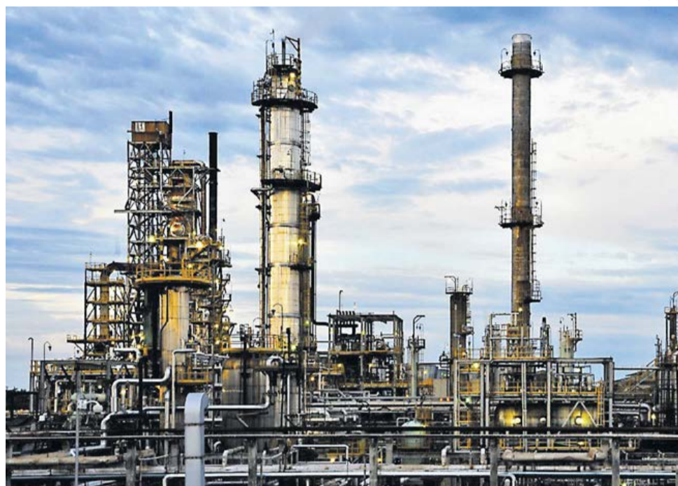
Instalaciones de la refinería de Ecopetrol ubicada en Barrancabermeja
