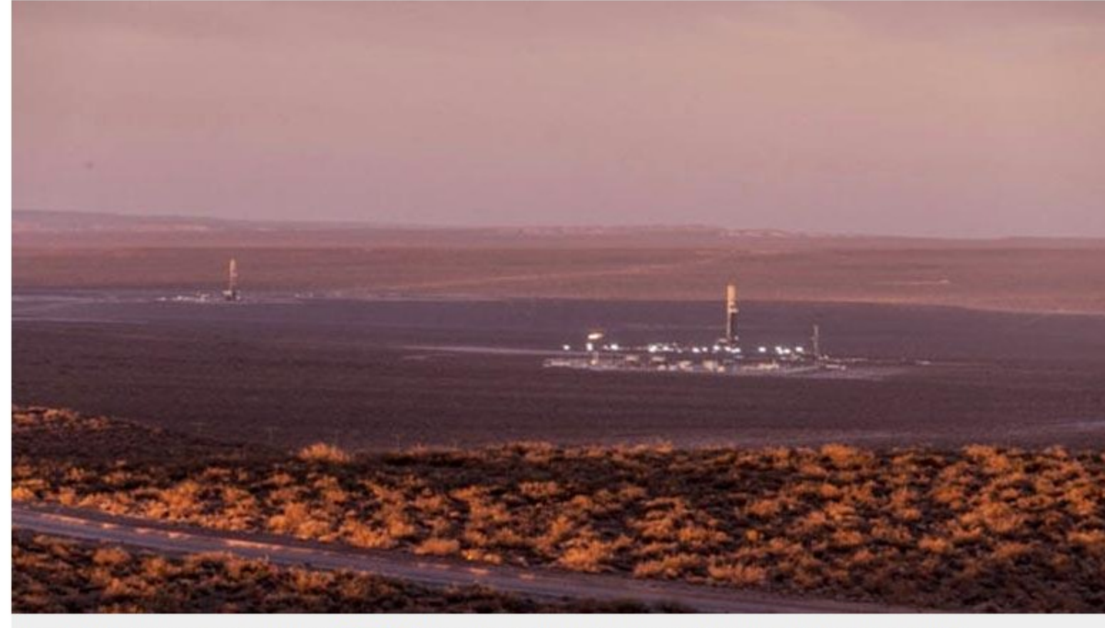
Una de las instalaciones para procesar el petróleo y el gas de esquisto de Vaca Muerta, en Argentina. Eduardo Carrera / PXP
