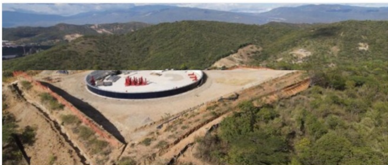
El sub proyecto 4 registra avance del 37 % (corte 30 de julio). / Fotos: PRENSA ECOPETROL
