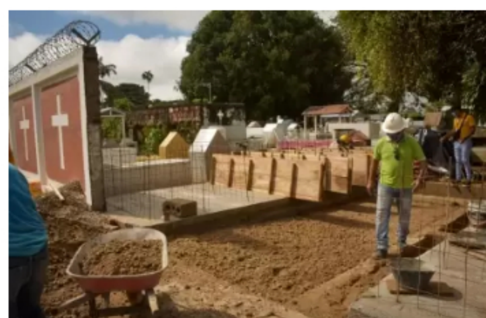
Por Covid-19 construyen bóvedas y amplían el cementerio de Arauca
