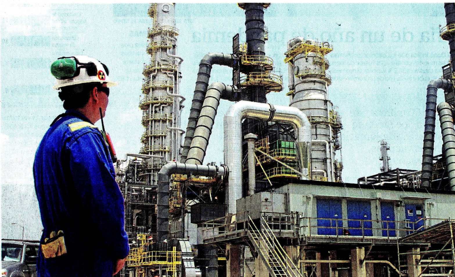
Para la Contraloría, el daño al patrimonio fue producto de las acciones y omisiones de la junta directiva de Reficar y su administración, contratista y supervisor del proyecto.
