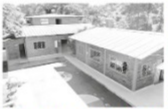
La remodelación, reconstrucción y dotación de la Escuela la Lizama 2 ubicada en Copetrol y la generación beneficiará a más de 130 estudiantes.
