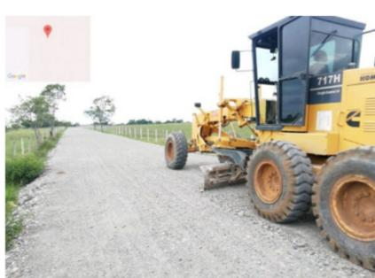
El mejoramiento de estas vías, que contó con una inversión de \$5.540 millones por parte de **Ecopetrol**, incluyó ampliación por ambos costados, atención de los puntos críticos con compactación de material afirmado y construcción de alcantarillas para el manejo de las aguas lluvias.
