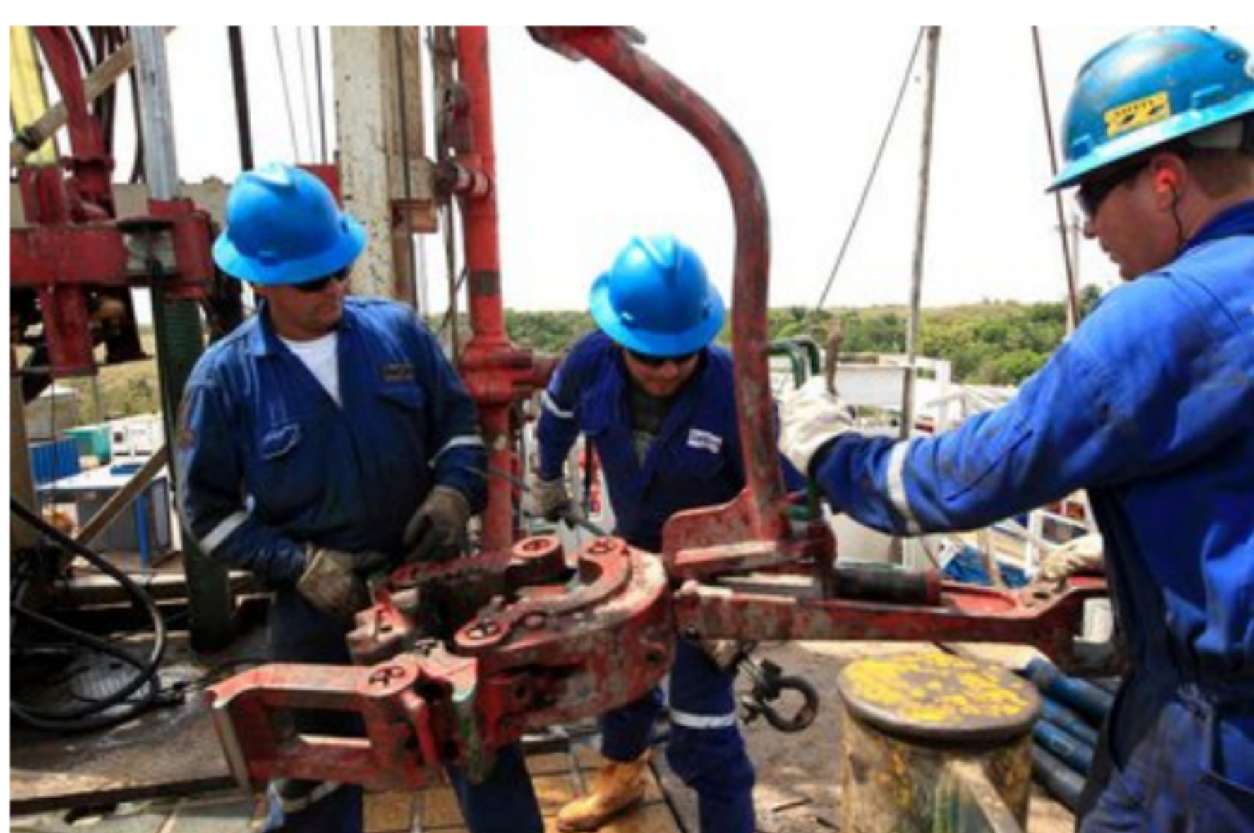
Foto de archivo. Empleados laboran en la excavación de oleoductos en el campo Rubiales, en el departamento del Meta, Colombia, 23 de enero de 2013. REUTERS / José Miguel Gómez
