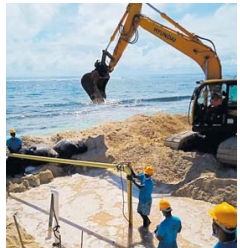
Trabajos en San Andrés.
