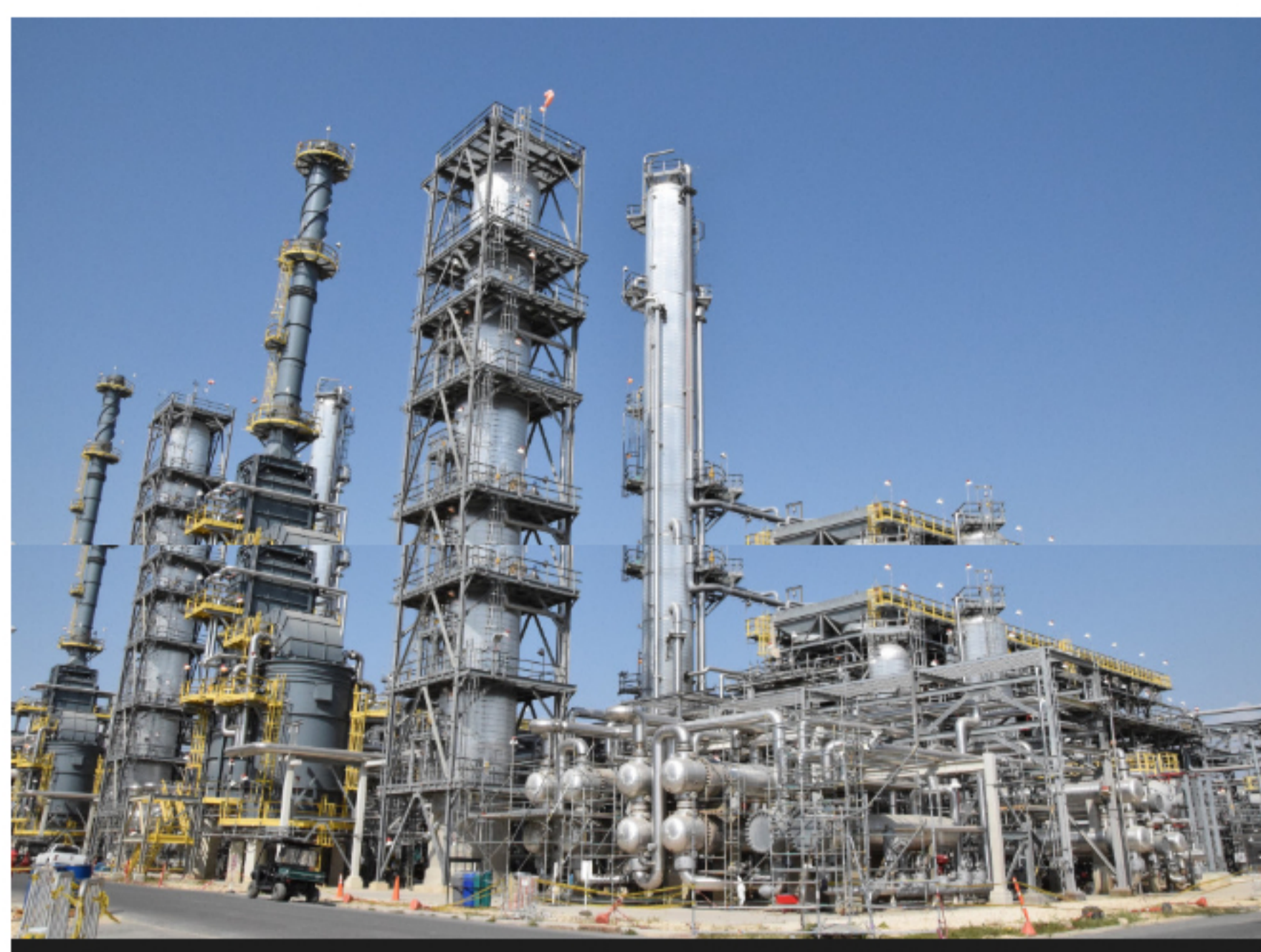
Trabajos de alta tecnología ejecuta Ecopetrol en la Refinería de Barrancabermeja. / Cortesía
