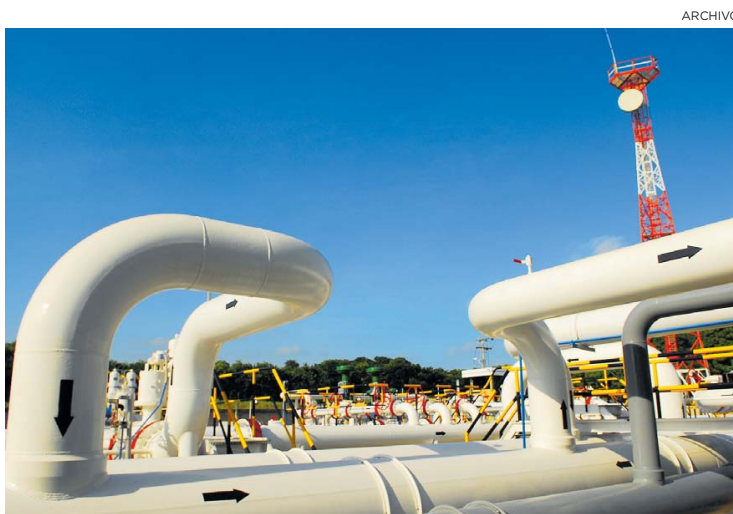
Tuberías en planta de gas desde donde se envía el combustible centros urbanos.
