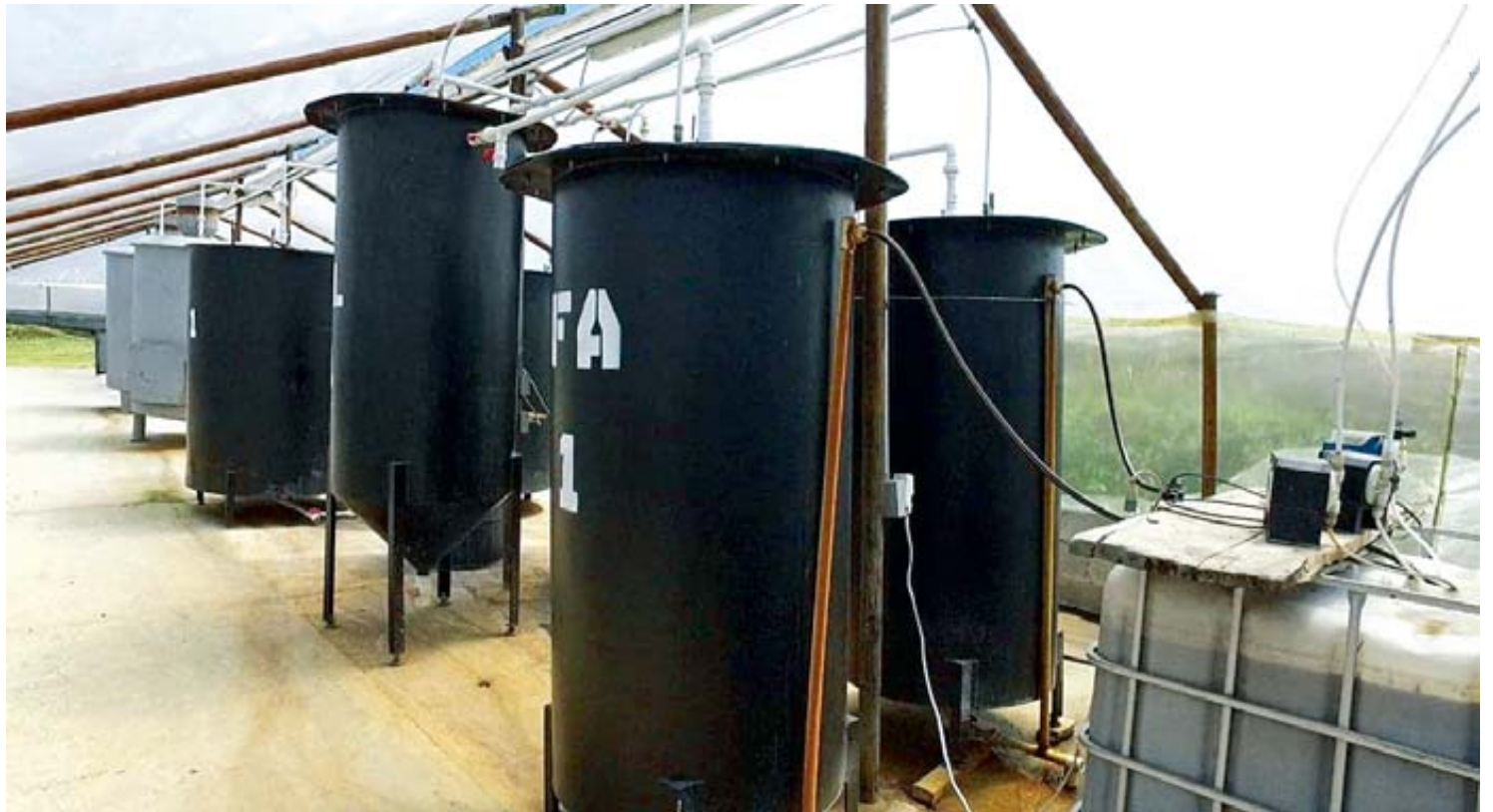
En estos tanques de procesamiento de residuos se genera el biogás con el que se produce energía, por ahora utilizada para alumbrado público en una vía veredal del municipio de El Carmen de Viboral, en el Oriente antioqueño. FOTO CORTESÍA LA CIMARRONA
