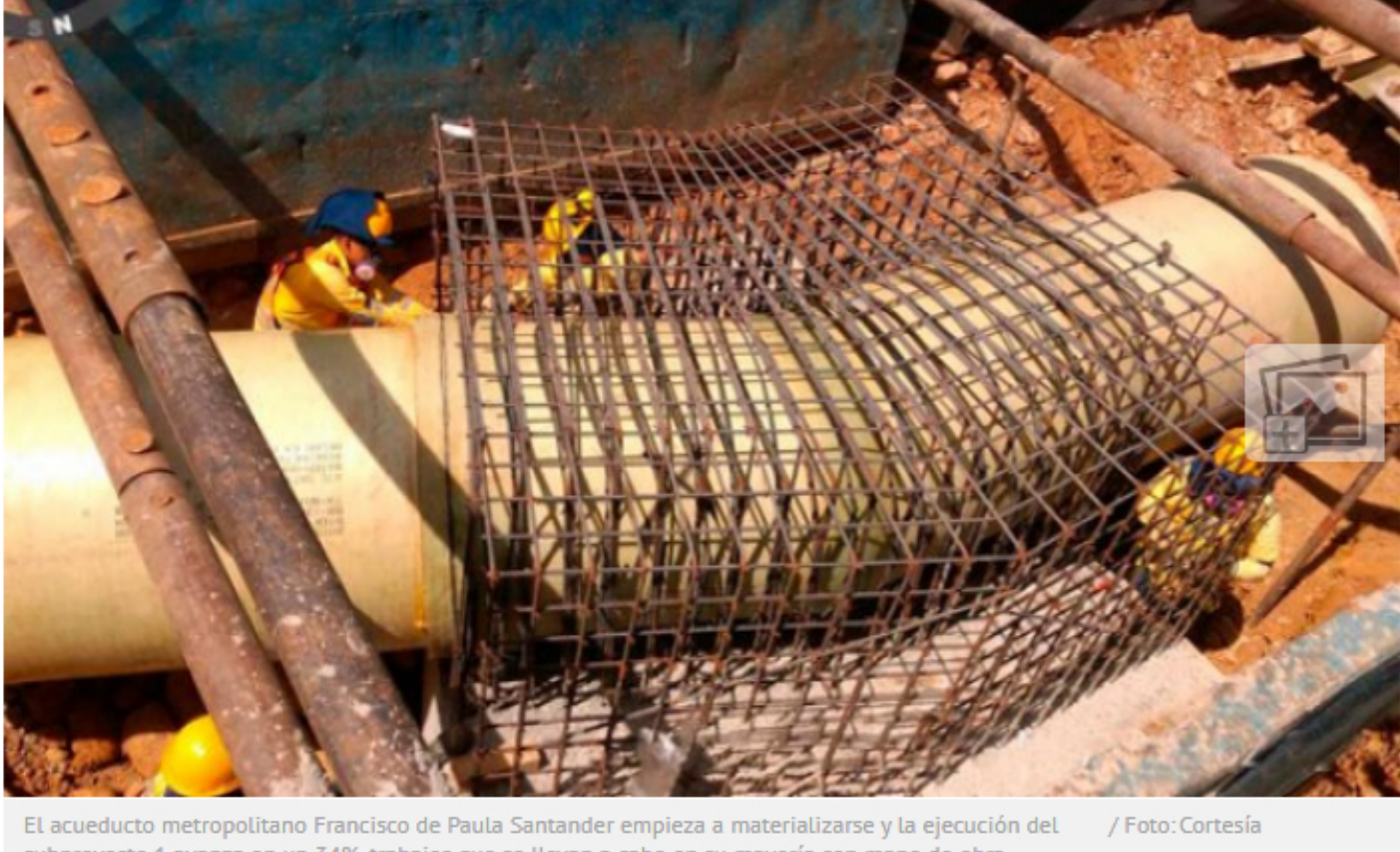
El acueducto metropolitano Francisco de Paula Santander empieza a materializarse y la ejecución del subproyecto 1 avanza en un 34%, trabajos que se llevan a cabo en su mayoría con mano de obra regional. / Foto: Cortesía
