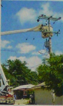
Un operario trabaja en el circuito.
