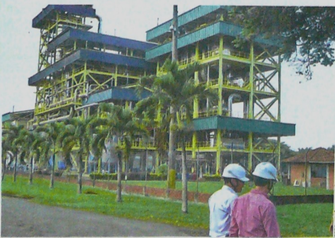
La planta de producción de etanol en el ingenio Providencia tiene capacidad para producir 300.000 litros diarios de este producto, a partir de 12.000 toneladas de caña.
