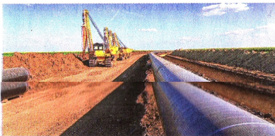
El sector trabaja bajo estrictas normas de seguridad y reiniciando algunas obras de construcción que habían quedado paralizadas. / Foto: iStock
