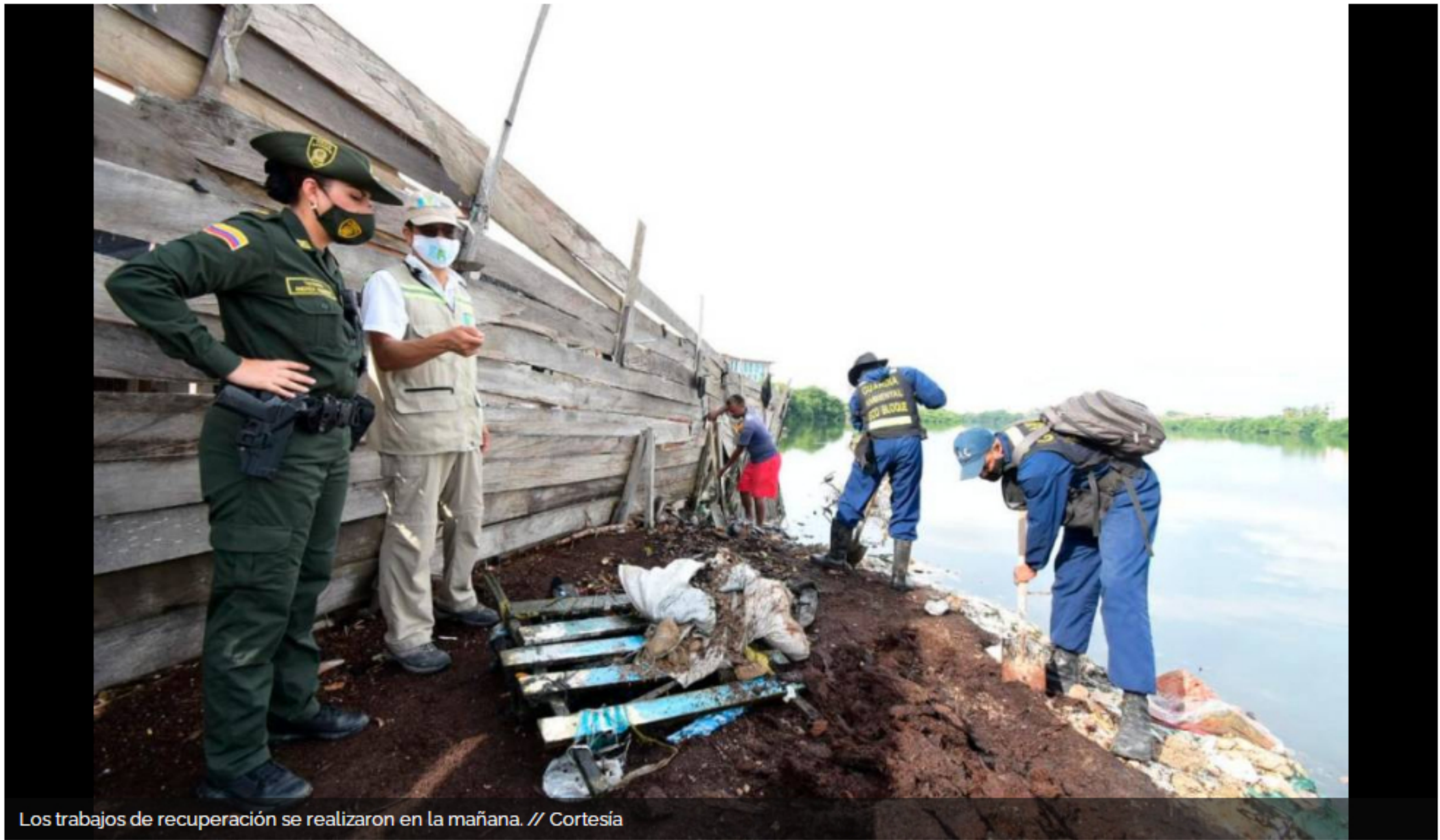
Los trabajos de recuperación se realizaron en la mañana. // Cortesía
