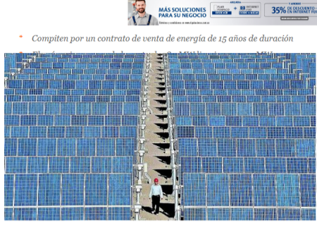
Imagen de una gran planta solar fotovoltaica
