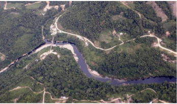
La emergencia fue provocada por una válvula ilícita. El equipo técnico de Ecopetrol estuvo en el cruce del río. Foto: Cortesía Ecopetrol.
