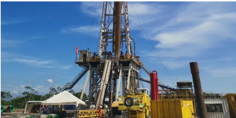
El pozo Flamencos-1 opera en el municipio de Puerto Wilches, Santander.
